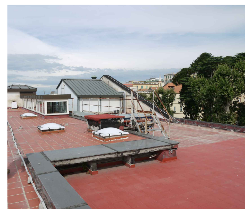
6-VISTA DA ORIENTE COPERTURA DELLA PASSERELLA E STRUTTUR IN FERRO DI COPERTURA DELLA POMPA DI CALORE ESISTENTE
